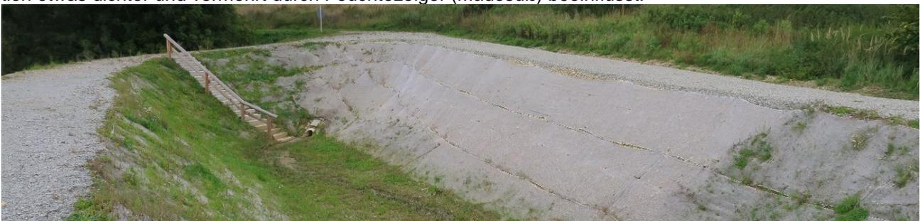
Abb. 10: unmittelbar im Südwesten außerhalb angrenzendes Regenrückhaltebeckens (RÜB) mit Jutebespannung
